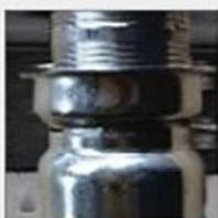
Enrosque o bocal de cobre na rosca da torneira retrátil.
